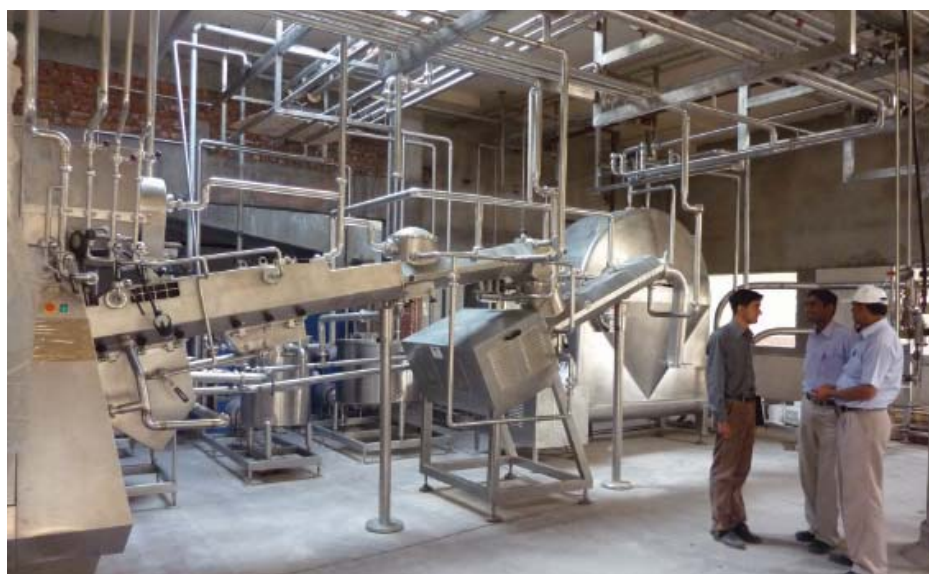
Installation d'un équipement Simon en Inde
